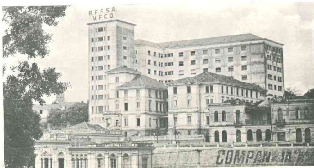
Este é o edifício-sede da VFCO, em pleno centro de Belo Horizonte e de onde o comando ferroviário se exerce sobre uma extensão de cerca de 3 mil Km distribuídos por Minas, Goiás, Estado do Rio e Guanabara.
