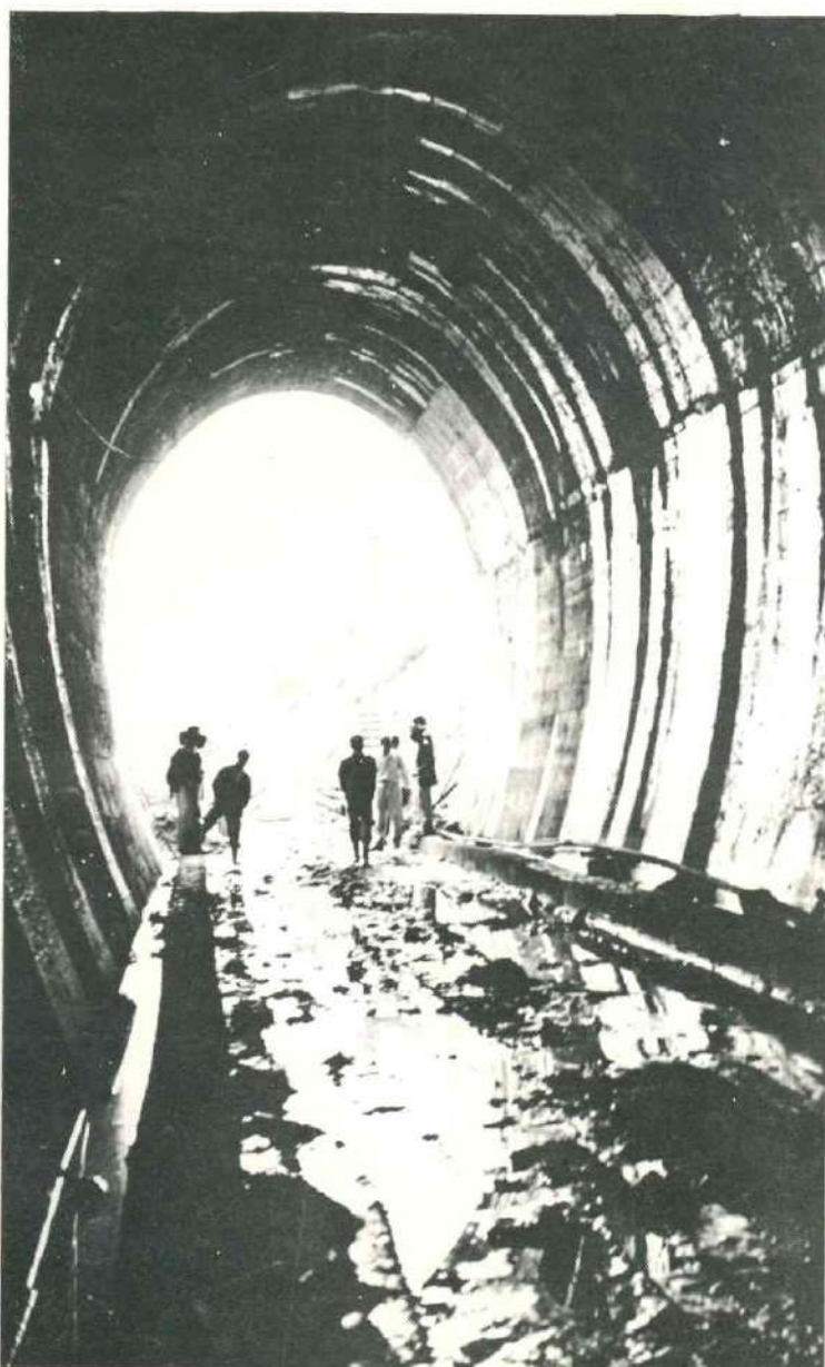
Com a dieselização da VFCO, muitos túneis tiveram de ser alargados e alterados; este é o túnel de Tartária, no trecho Divinópolis-Costa Pinto.
