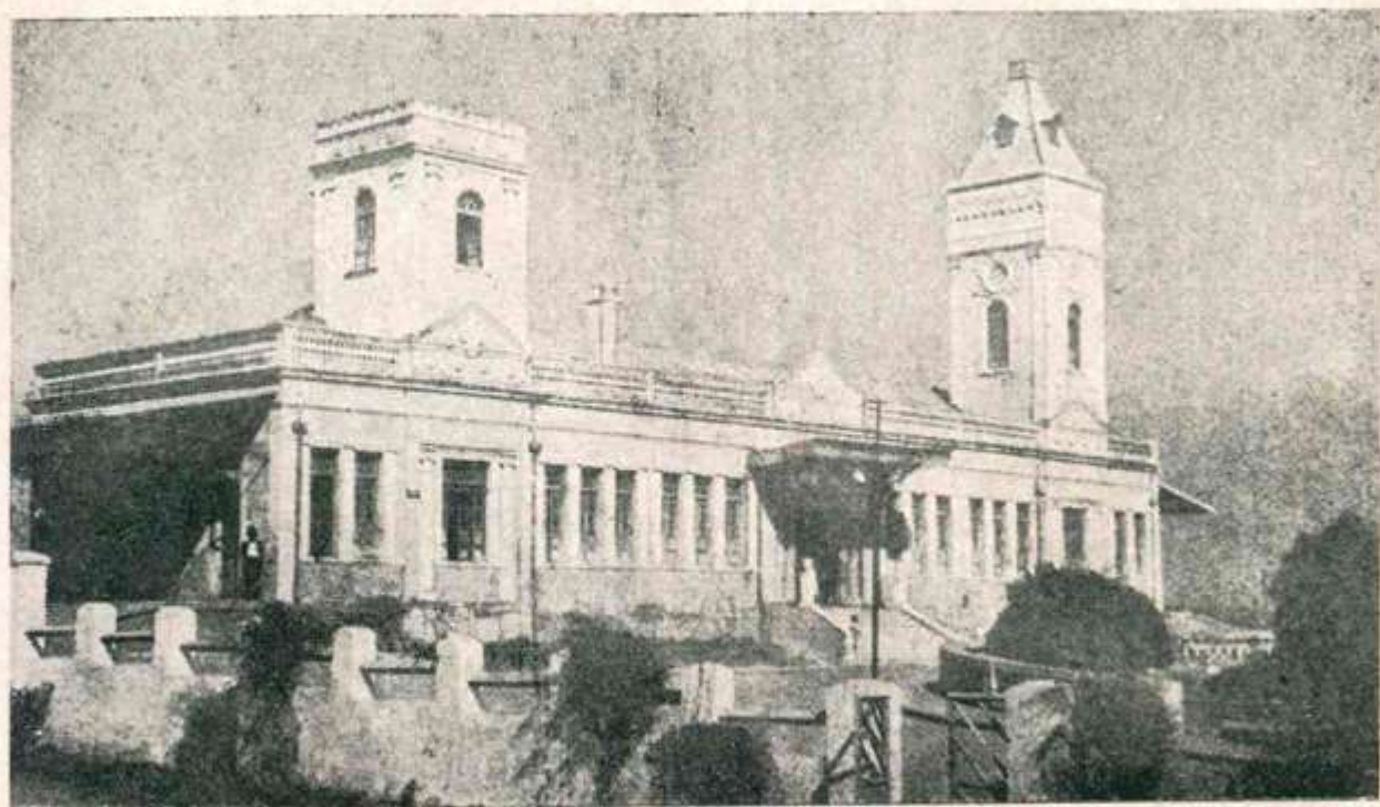
A bela estação de Araxá
