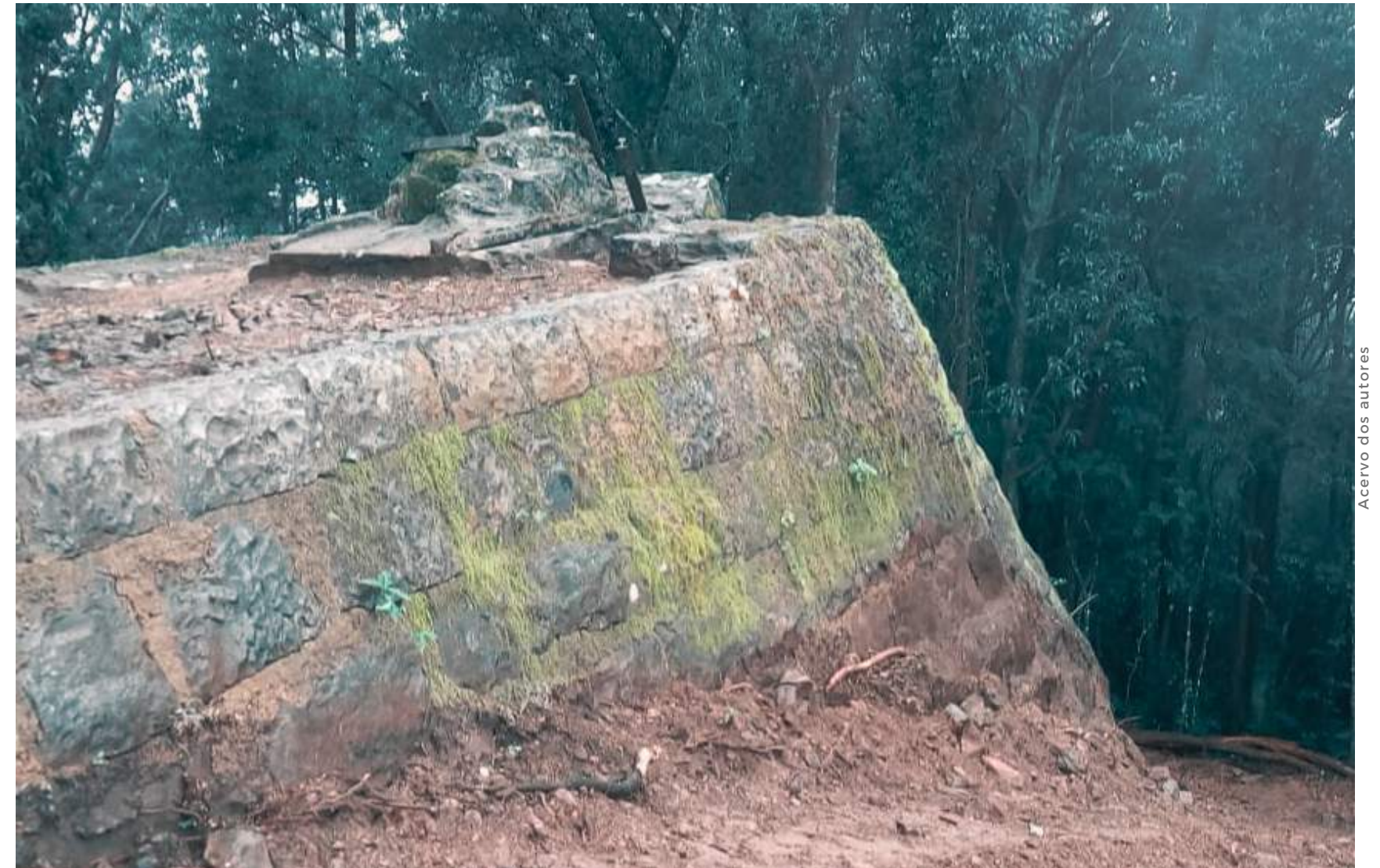
Muro Parador (ou para-choque) na ponta superior do Rabicho (2019). Resquício de arqueologia industrial preservado na localidade Altos da Viação, no bairro Várzea Grande, em Gramado-RS.
